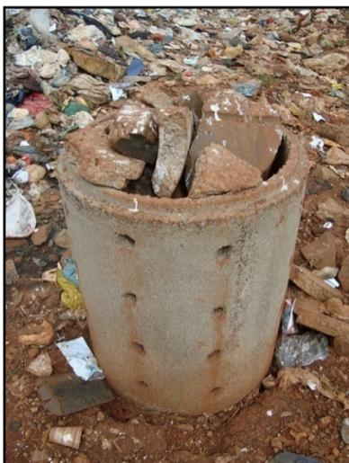
**Figura 10.2-LXI: Dreno de captação de gases**
