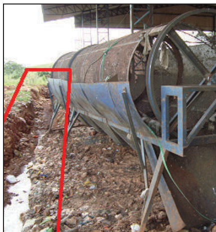
Figura 10.2-LII: Calha coletora de chorume
