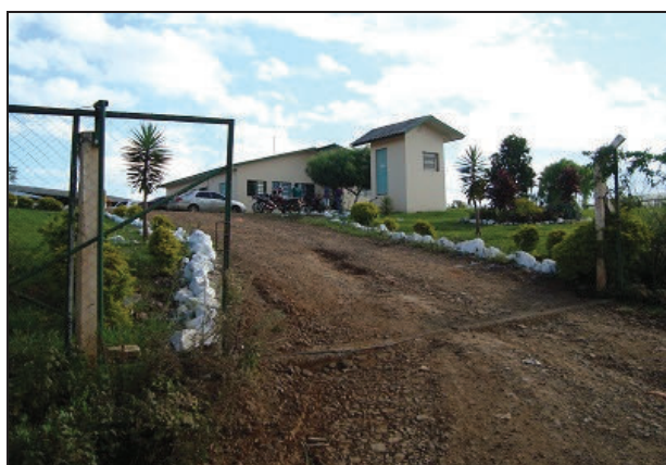
Figura 10.2-XXX: Portão e guarita na entrada Usina de Reciclagem e Compostagem CONILIX
