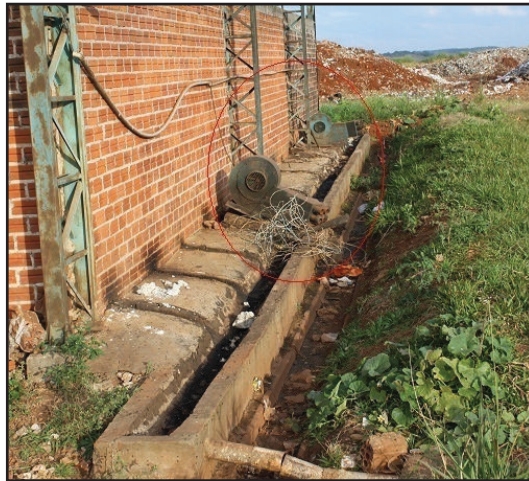
Figura 10.2-XLVIII: Aeradores fora de operação
