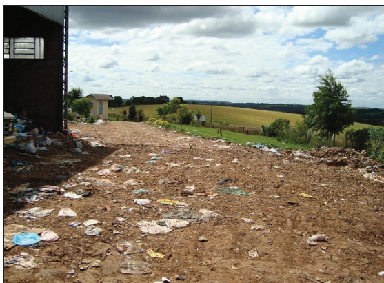
Figura 10.2-XXXII Acesso à ÁREA DE
