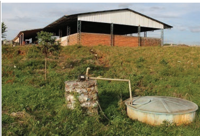
Figura 10.2-LIII: Caixa coletora de chorume e bomba de recalque
