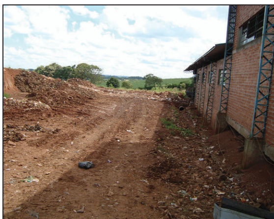
Figura 10.2-LIV: Área lateral do galpão de triagem, prevista para ampliação da COMPOSTAGEM – entre o galpão de triagem e o ATERRO SANITÁRIO
