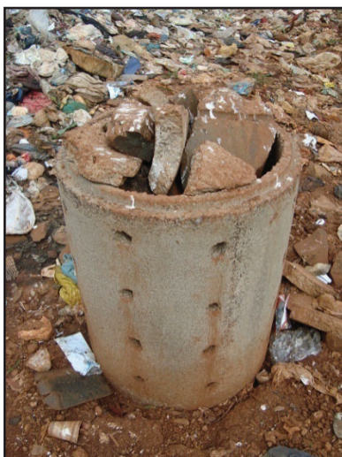
Figura 10.2-LXI: Dreno de captação de gases
