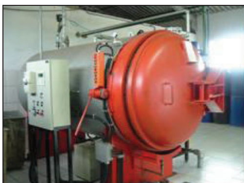
Figura 10.2-LXXVIII: Foto da autoclave (Fonte: Atitude Ambiental)
