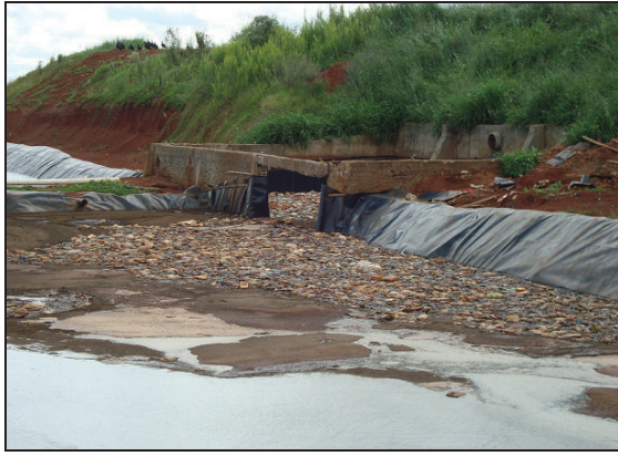
Figura 10.2-LVII: Lagoas de tratamento 1 e 2
