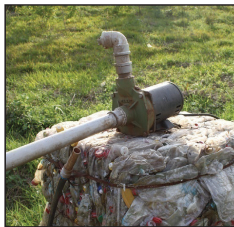
Figura 10.2-LX: Bomba de Recirculação de Chorume
